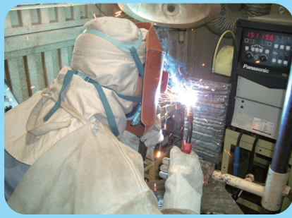
CO 2 ・MAG溶接
